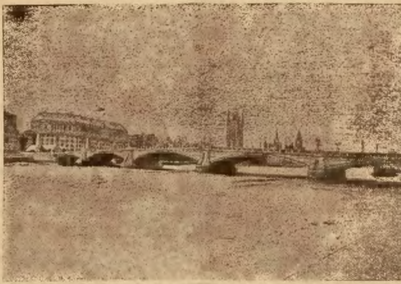
W dniu 19 b. m. odbyło się w Londynie otwarcie i oddanie do użytku publicznego nowowbudowanego na Tamizie mostu, t. zw. mostu Lambeth. Otwarcia mostu dokonał król w obecności kilkuset tysięcy tłumów ludności Londynu. Budowa tego mostu trwała 3 lata.
