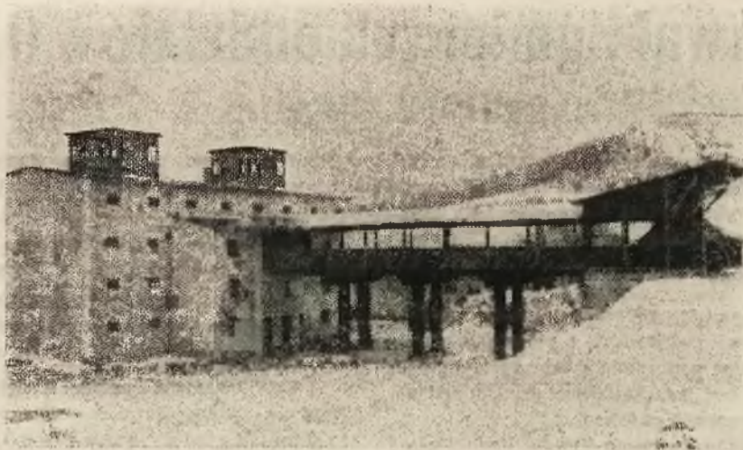
Elevator zbożowy w Krzemieńcu, eksploatowany przez miejscową spółdzielnię rolniczo-handlową producentów rolnych, obecnie całkowicie zmechanizowany, po otrzymaniu 4 wyciągów mechanicznych i całkowitych urządzeń do oczyszczania ziarna.
