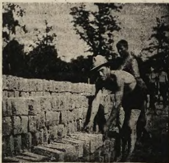
Układanie cegły do suszenia pod daszkami po bokach placów strycharskich.
