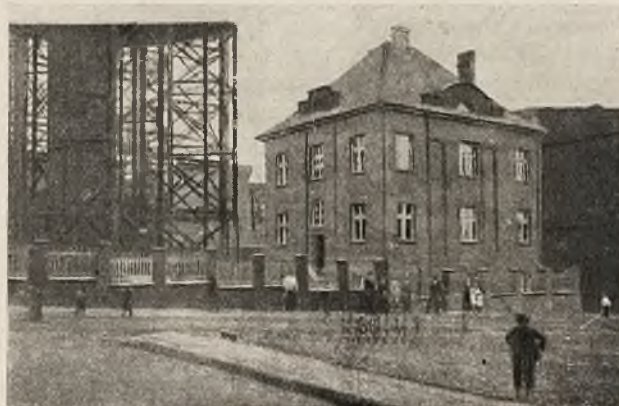
Dom służbowy w Stacji Pomp.
