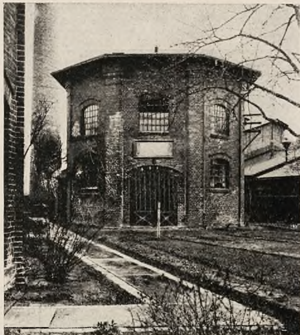
Wejście do Szybu „Staszica“ w Stacji Pomp.
