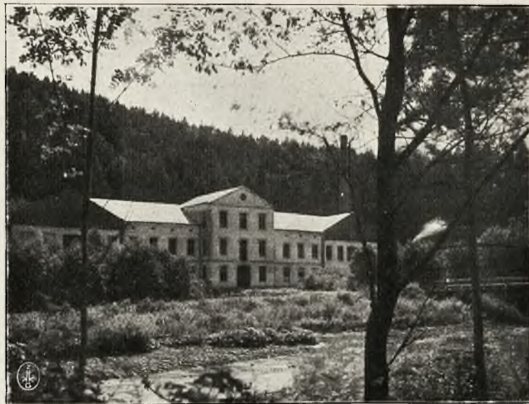
Rymanów — Łazienki. Rymanów — Etablissement de bains. Rymanów — The Bath. Rymanów — Kurhaus.
