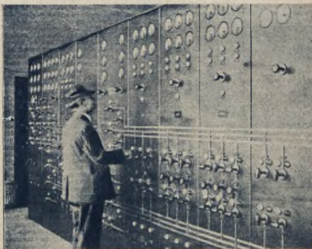
Ogromna tablica rozdzielcza, gdzie są zgrupowane przyrządy do kontrolowania wentylatorów
