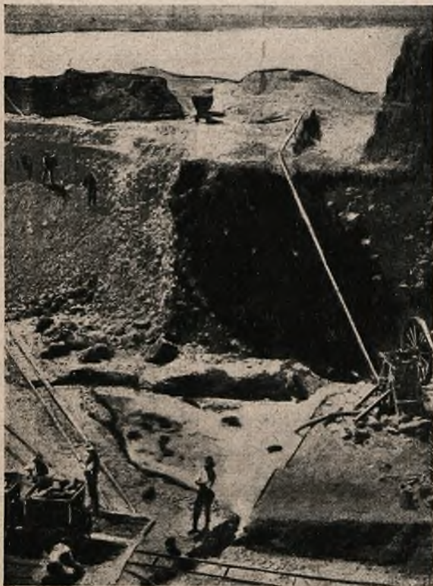
Pompy zabezpieczają miejsce pracy od zalewu wody.
