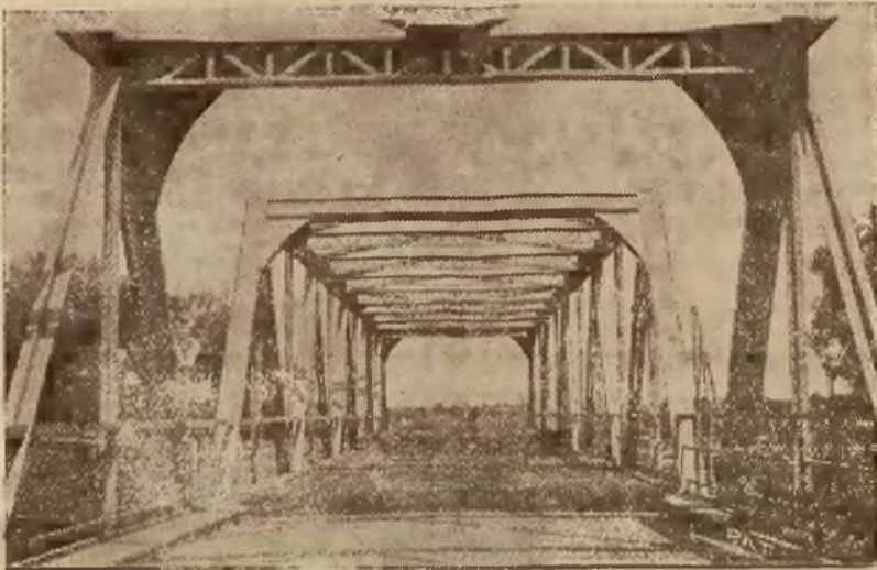
Na rzece Muchawcu pod Brześciem n. B. stanął żelazny most drogowy, długości 75 m. Podajemy fotografię nowego mostu.
