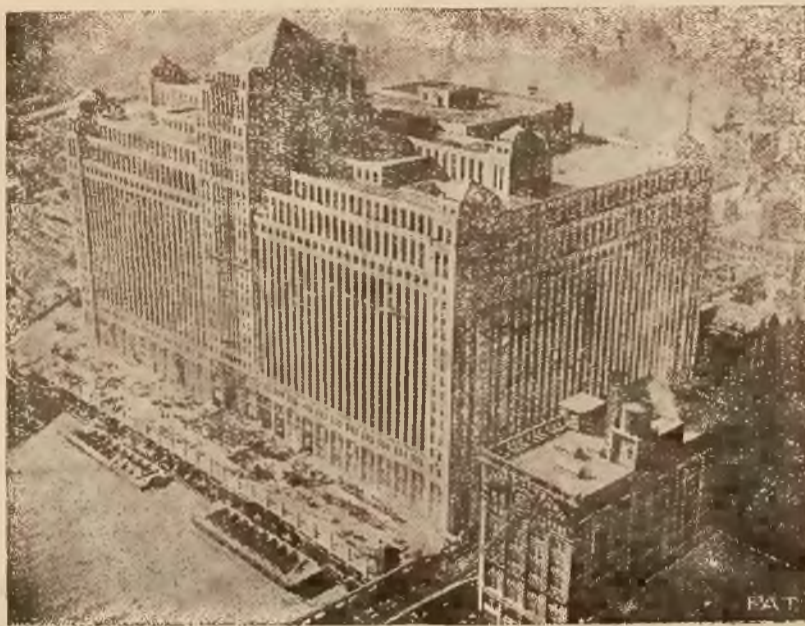
„Merchandise Mart” Chicago mieści całe miasto składów towarowych pod jednym dachem. Jest to najobszerniejszy gmach na świecie.
