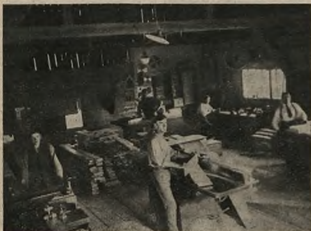
Miejsce Piastowe. W maszynowni stolarskiej.
