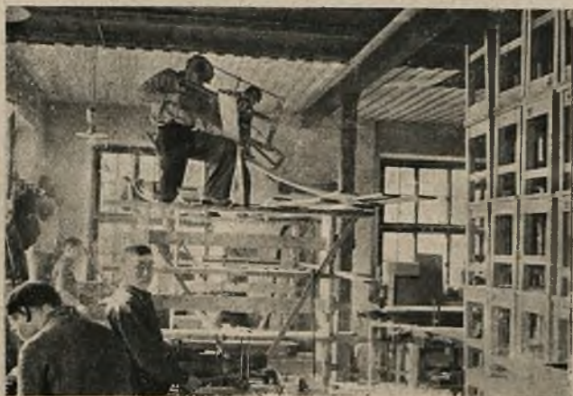
Pawlikowice. Stolarczyki wykonują sufit.
