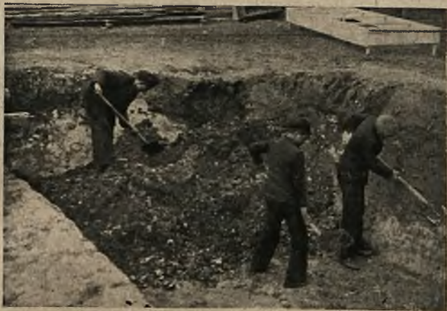
Pawlikowice. Trzeba wykopać dół dla wapna.
