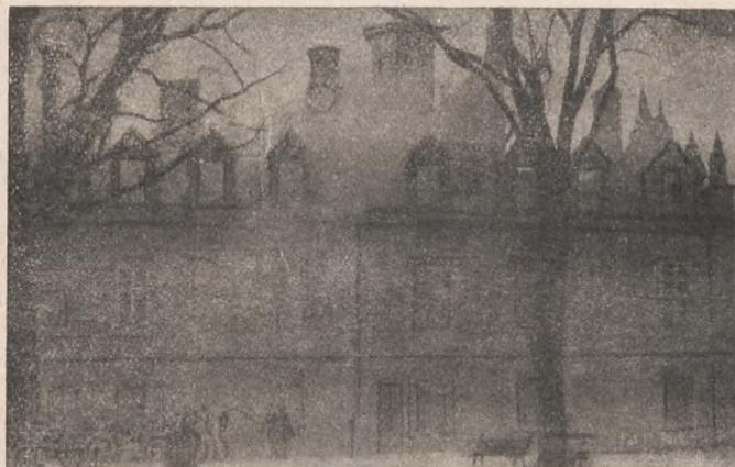
Pałac w Dzikowie w czasie pożaru.
