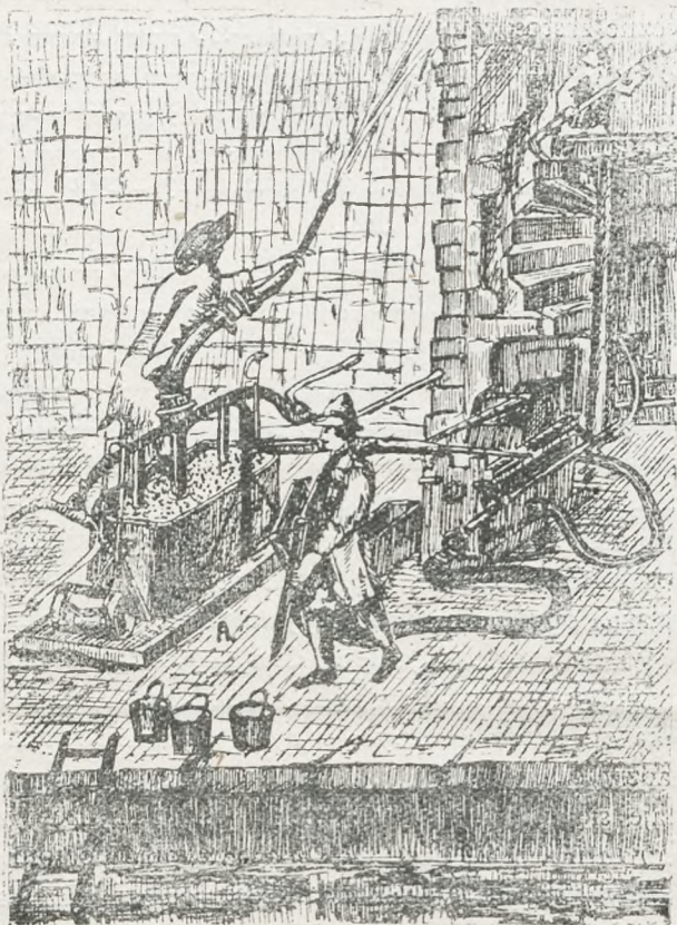
Rys. 3. „Sikawka z XVII i XVIII wieku A. — z rurą skrętną i skrzynią wodną, wypełnianą za pomocą kubelków. B. — z węzłem tłoczonym i pierwotnym węzłem ssawnym”.
