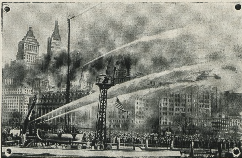
„Wieża wodna” przeciw pożarom. W Nowym Jorku wprowadzono nowe urządzenia przeciw niebezpieczeństwu pożarów w porcie nowojorskim. Jest to t. zw. „wieża wodna”, która może wyrzucić 7.000 galonów wody na minutę. — Ryc. powyższa przedstawia ową „wieżę wodną”, w czasie próby dokonanej w N. Jorku.
