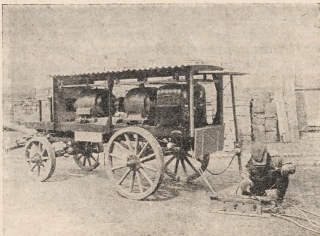
Ruchomy elektrogenerator do spawania elektrycznego.
