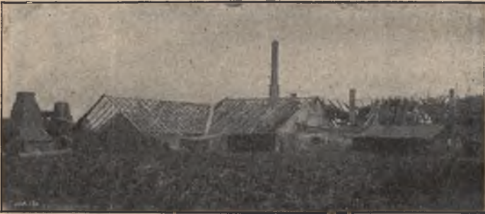
Zniszczenie domów , spowodowane przez wybuch prochowni w Woli Duchackiej pod Krakowem.
