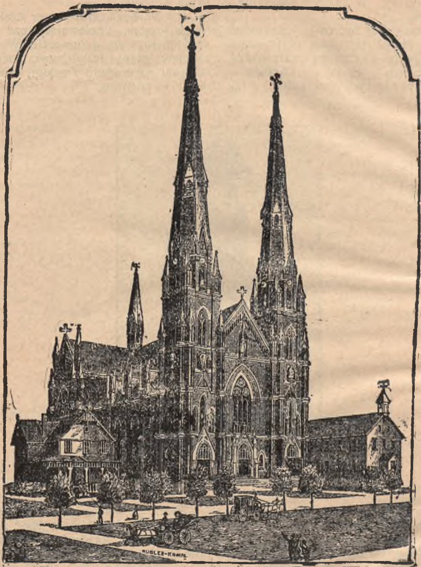
Kościół św. Stanisława w Cleveland, Ohio, przed katastrofą. Kościół ten uległ zniszczeniu podczas burzy w dniu 21 kwietnia, 1909 roku.
