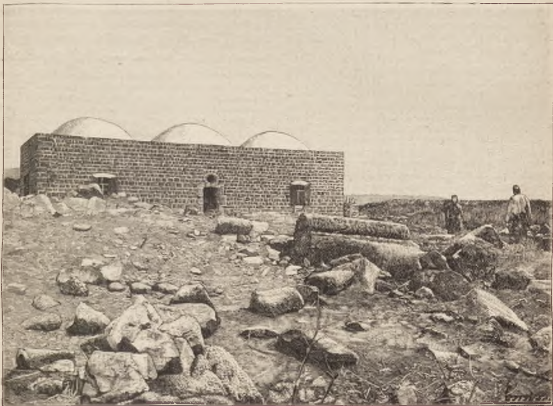
66. — Édifice construit à Tell-Houm par les Franciscains. D'après une photographie de M. L. Heidet.
