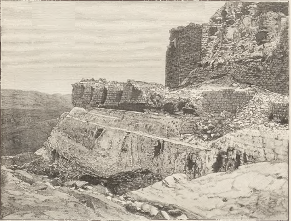
320. — Kir Moab. Vue du Grand Birket en-Naser et du fossé taillé dans le roc. D'après de Luynes, Voyage à la mer Morte , pl. 7.
