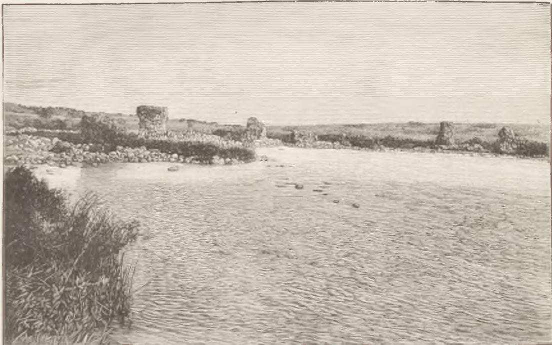
298. — Le Jourdain au-dessous du lac de Tibériade et ruines de Djisir-es-Sidd . — A droite, rive orientale; à gauche, rive occidentale. Six piles du pont, en pierres de basalte et ciment très dur. — D'après une photographie de M. L. Heidet.
