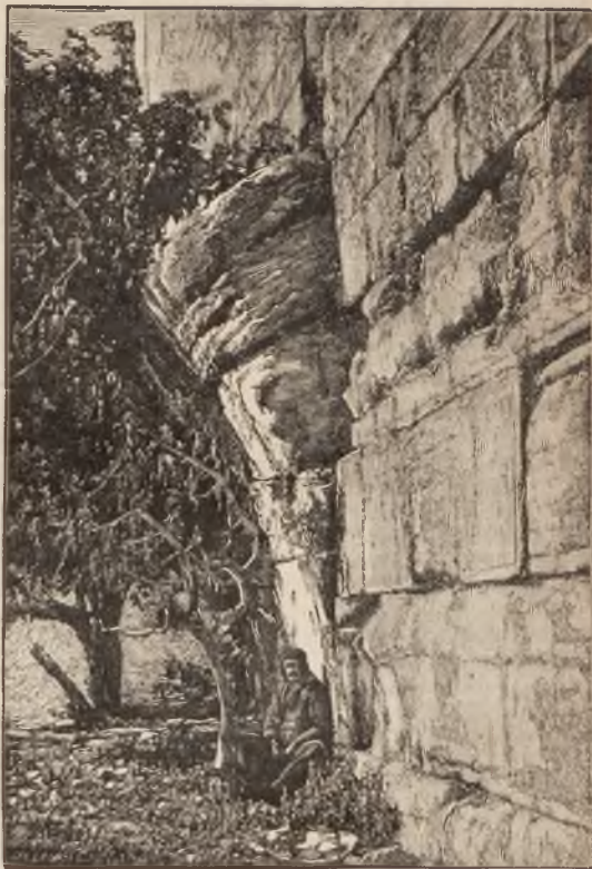
256. — Arche de Robinson. D'après une photographie.
