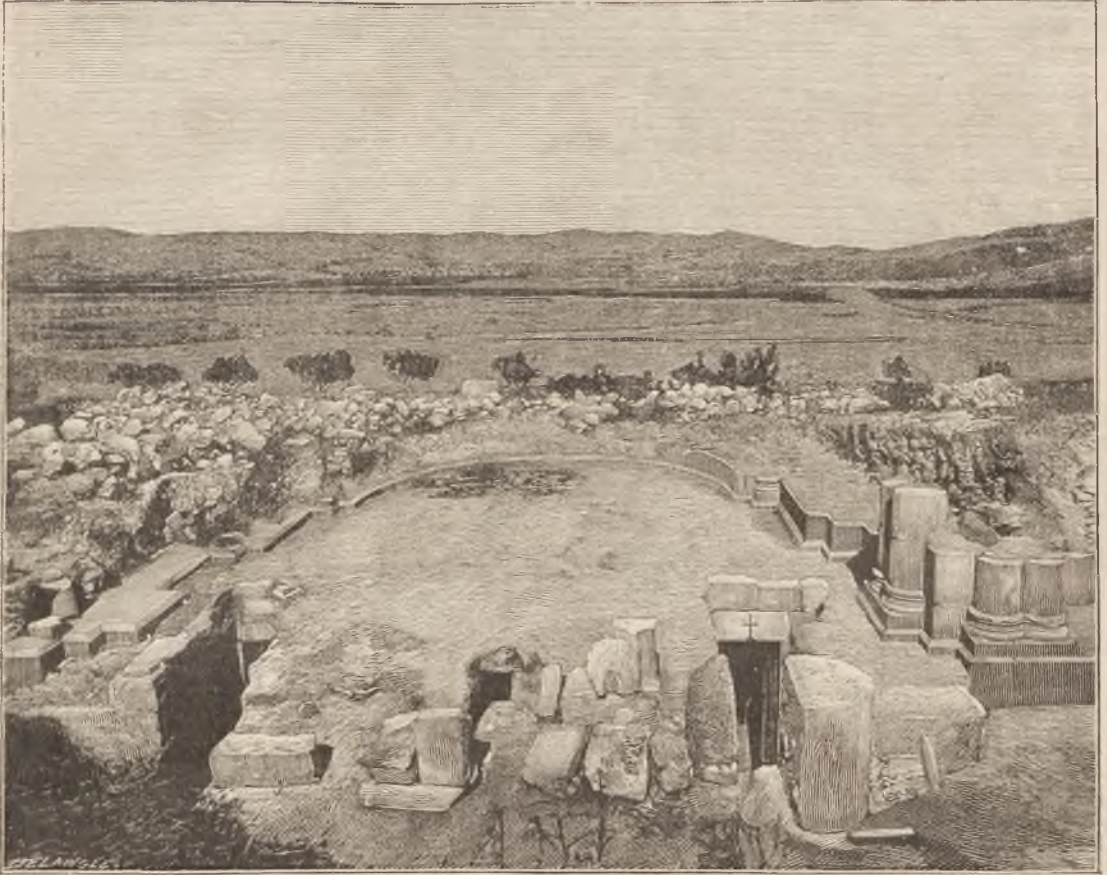
197. — Abside de l'église de la Samaritaine. Entrée de la crypte renfermant le puits de Jacob. D'après une photographie du P. Henrik.
