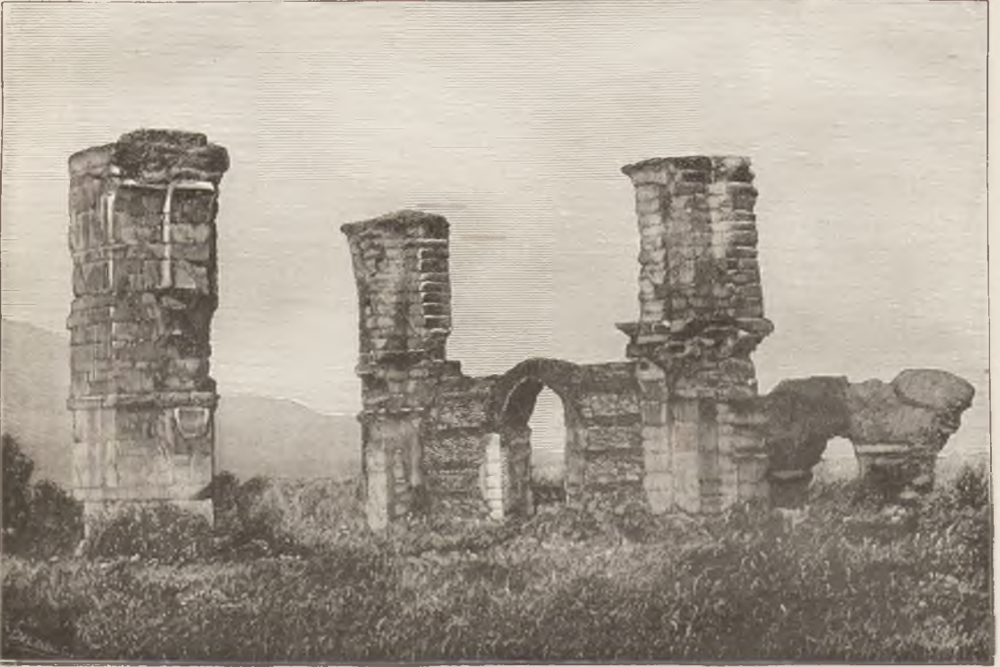
67. — Ruines du Dircëir à Philippes. D'après une photographie.
