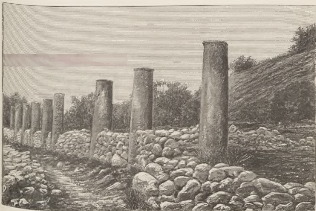
288. — Colonnade de Sébasijééh (d'est en ouest). D'après une photographie de M. L. Heidet.
