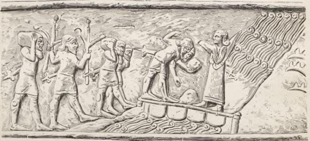
122. — Construction d'un pont par les Assyriens pour passer une rivière. D'après Gates of Balawat , pl. 74.
