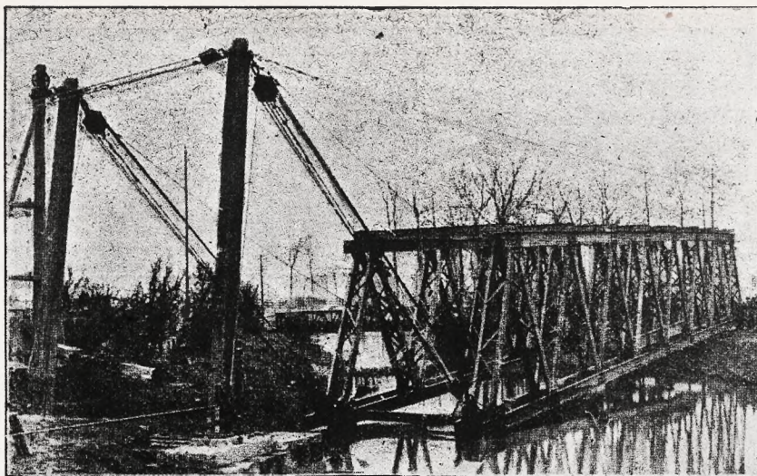
Nasuwanie przęsła syst. Hopkinsa (36,6 m.).
