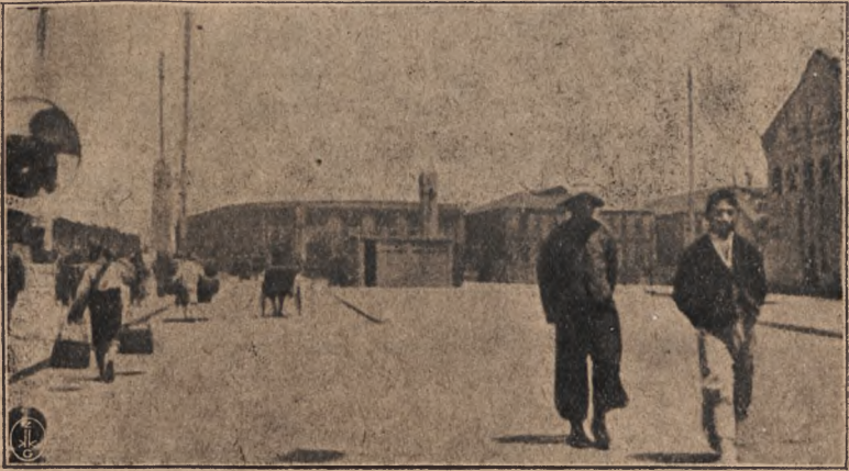
Rys. 1. Blokhauz betonowy, ostrzeliwujący przedmoście i ulicę.
