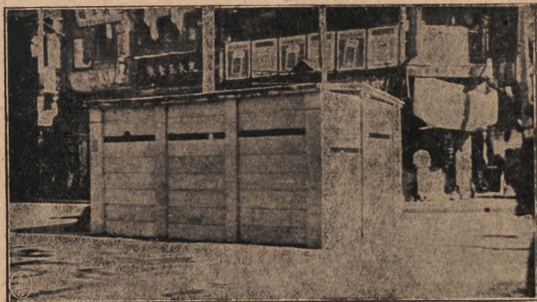
Rys. 7. Blokhaus betonowy, widziany z bliska.
