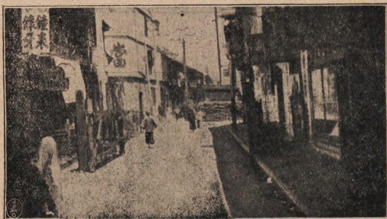
Rys. 4. Typowy przykład obrony ulicy. Na przednim planie brama na kółkach, w głębi, na rogu ulicy — betonowy blokhauz.
