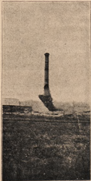
Rys. 2. Kolejne stadja wysadzenia komina w Aberdeen.
