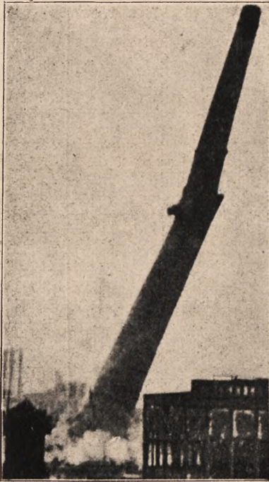
Rys. 1. Wysadzenie komina 110 metrowego w St. Zj. Am. Płn.
