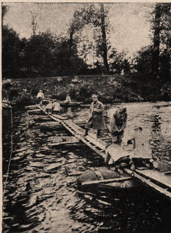
Ćwiczenia w budowie kładki na pływakach przez 1 kompanję 4 pułku inżynieryjnego.
