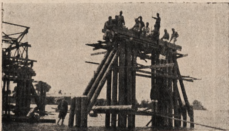
Budowa mostu półstałego.
