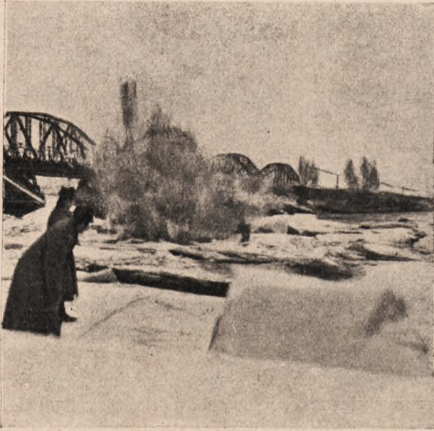
Wysadzanie zatorów lodowych na Wiśle pod Sandomierzem w 1928 r. przez 4 pułk saperów.
