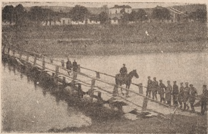
Kładka na Sanie zbudowana przez 10 pułk saperów.
