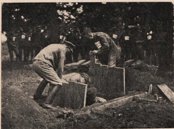
Zawody saperskie na Powązkach. Budowa studni minerskiej.
