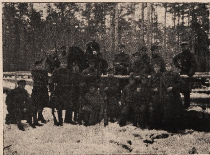
Budowa drogi na bagnach nad Styrem. Luty 1916.
