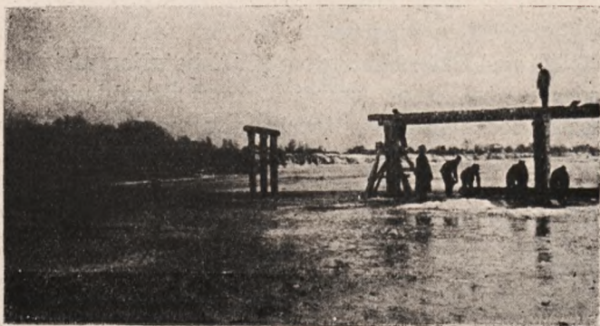
Budowa mostu na Świsłoczy, r. 1919, przez VIV bat. saperów.
