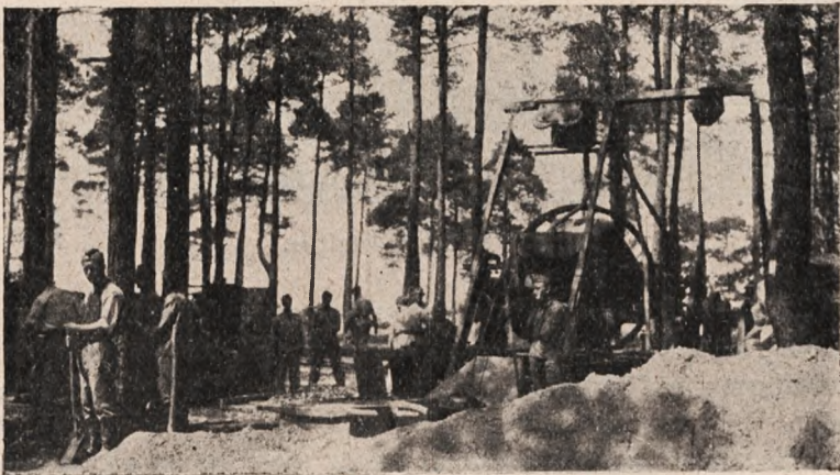
Przygotowawcze roboty betonowe.
