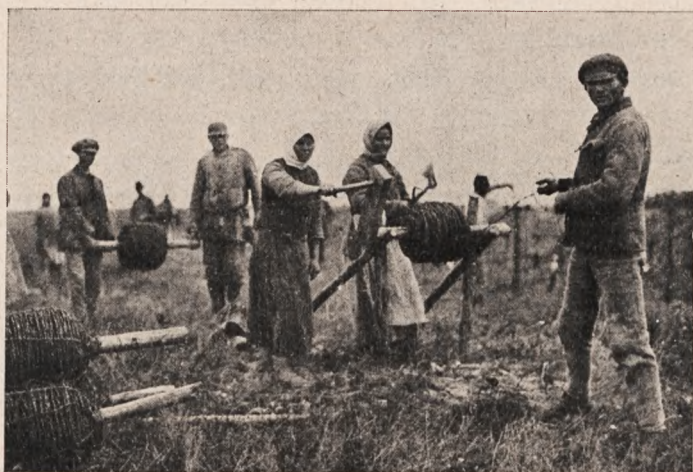
Zwijanie drutu kolezastego przez robotników cywilnych.
