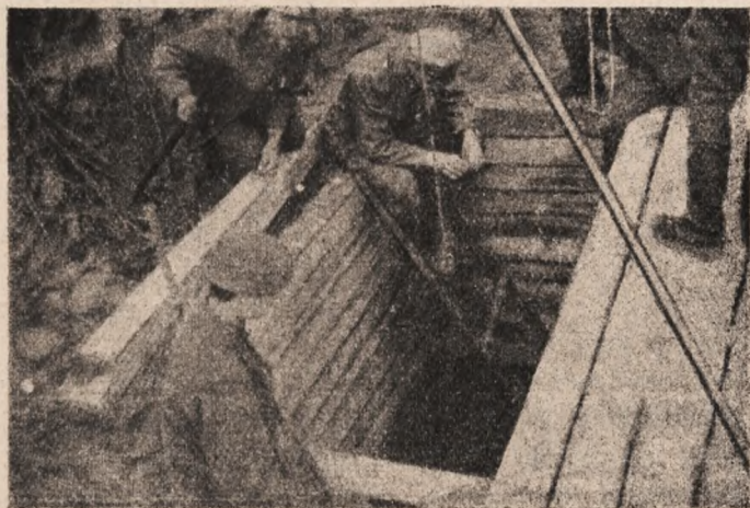
Budowa chodnika minerskiego w „Reducie Piłsudskiego”. Maj 1916 r.
