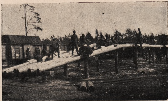
Budowa rampy kolejowej.
