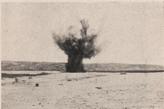
Wysadzanie zatorów lodowych na Wiśle. R. 1925.
