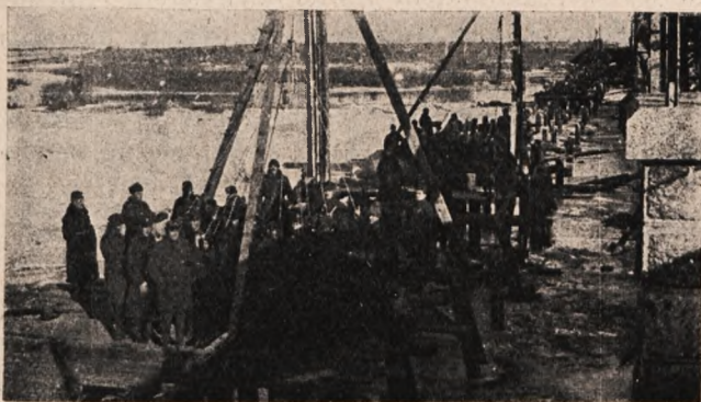
Budowa mostu na Horyniu pod Antonówką; zabijanie pali.
