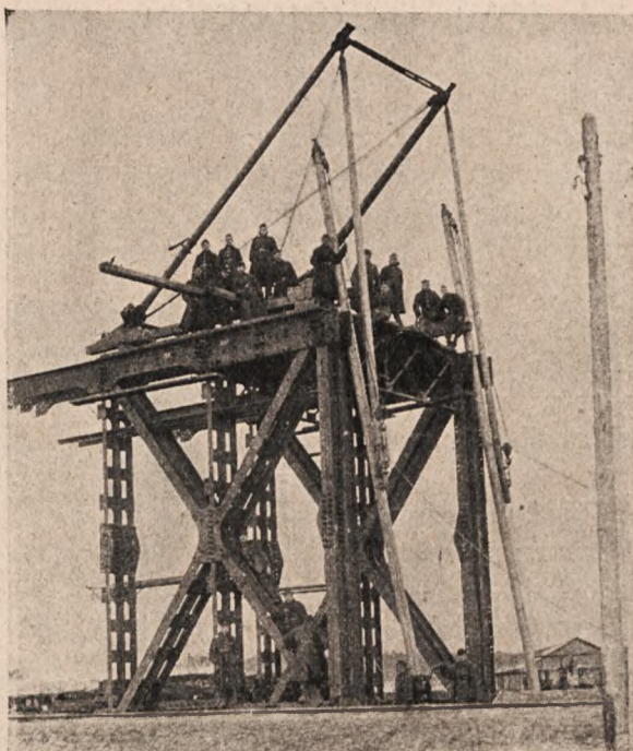
Budowa mostu składanego.
