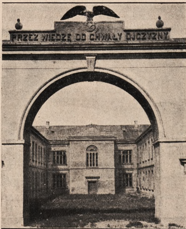
Fragment budynku mieszkalnego podchorążych Szkoły Podchorążych Inżynierji.
