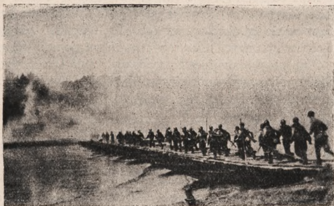
Forsowanie Warty pod Biedruskiem przez piechotę na kładce, zbudowanej na puchówkach, z zastosowaniem zastony dymnej. Rok 1927.
