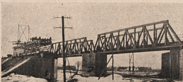
Budowa mostu w Tczewie w 1928 r.
