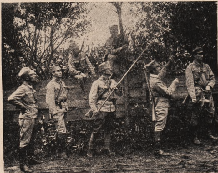
Budowa linii telefonicznej.
