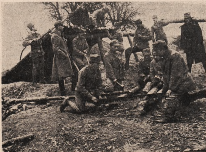
Budowa ziemianki przez telefonistów II Brygady Leg. Pol. w Maniewiczach.
