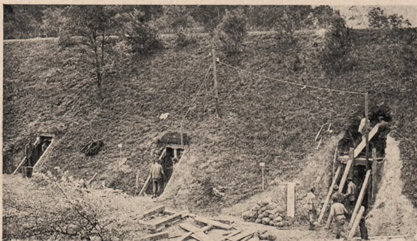
Rys. 7. Budowa schronów w zboczu.
