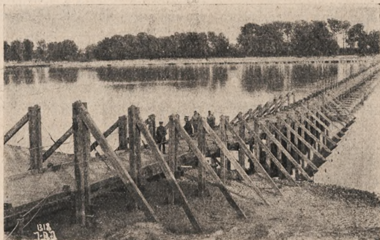
Rys. 1. Widok ogólny mostu.
