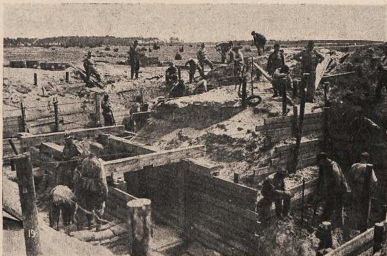
Rys. 7. Budowa schronu wykopowego.
