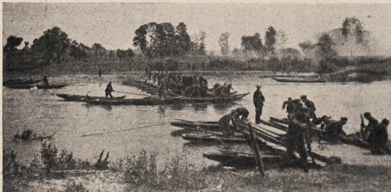
Rys. 3. Budowa mostu na puchówkach.
