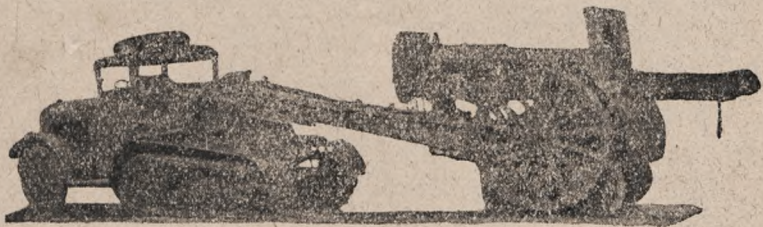
Rys. 38. Ciągnik artyleryjski C.-K. holujący haubicę o kal. 155 mm po drogach bitych.
