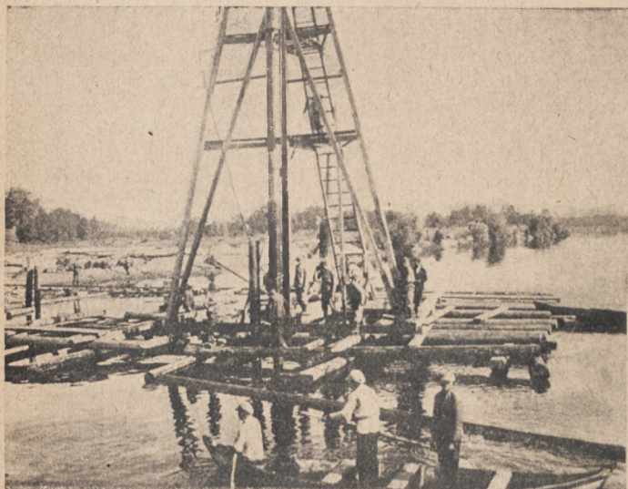
Rys. 77. Kafar parowy na rusztowaniu.
