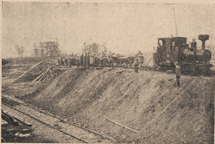
Rys. 84. Transport ziemi na nasyp.
