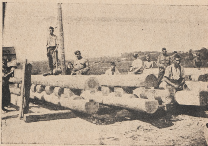
Rys. 78. Pasowanie dźwigarów głównych.
