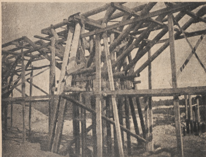
Rys. 76. Wykończone jarzmo z zastrzałami i rozpornicami.
