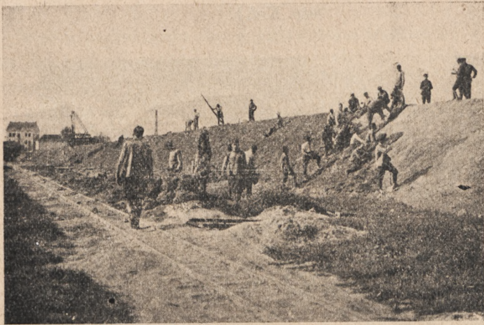
Rys. 86. Darniowanie skarp nasypu.
