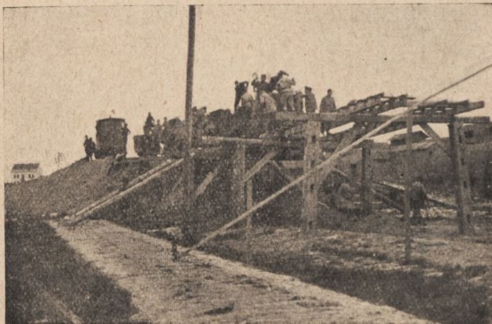
Rys. 85. Sypanie nasypu kolejowego „od czola“.
