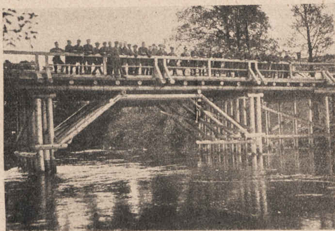
Rys. 95. Przęsło zastrzałowo - trapezowe.
