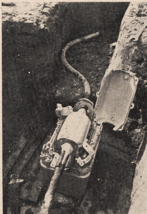
Rys. 14. Skrzynka z cewkami przed zamknięciem.
