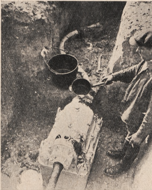
Rys. 15. Napętnianie masą izolacyjną.
