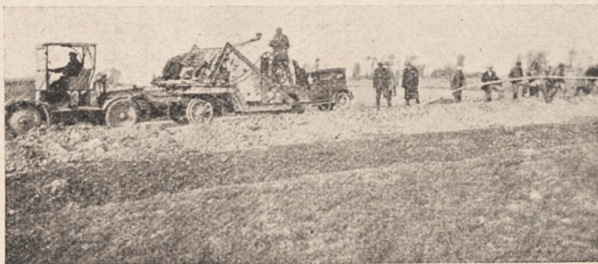
Rys. 5. Rozwijanie kabla zapomocą traktora.
