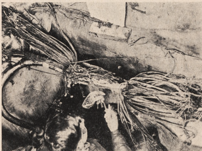
Rys. 8. Nasadzanie złóczek.
