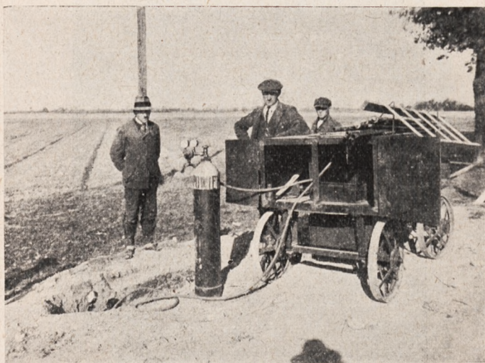
Rys. 16. Instalacja do przedmuchiwania kabla.
