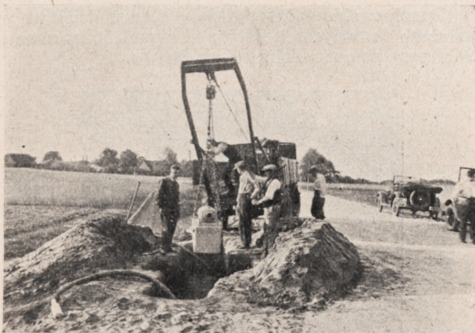
Rys. 12. Opuszczanie skrzyni z cewkami przy pomocy bloków.
