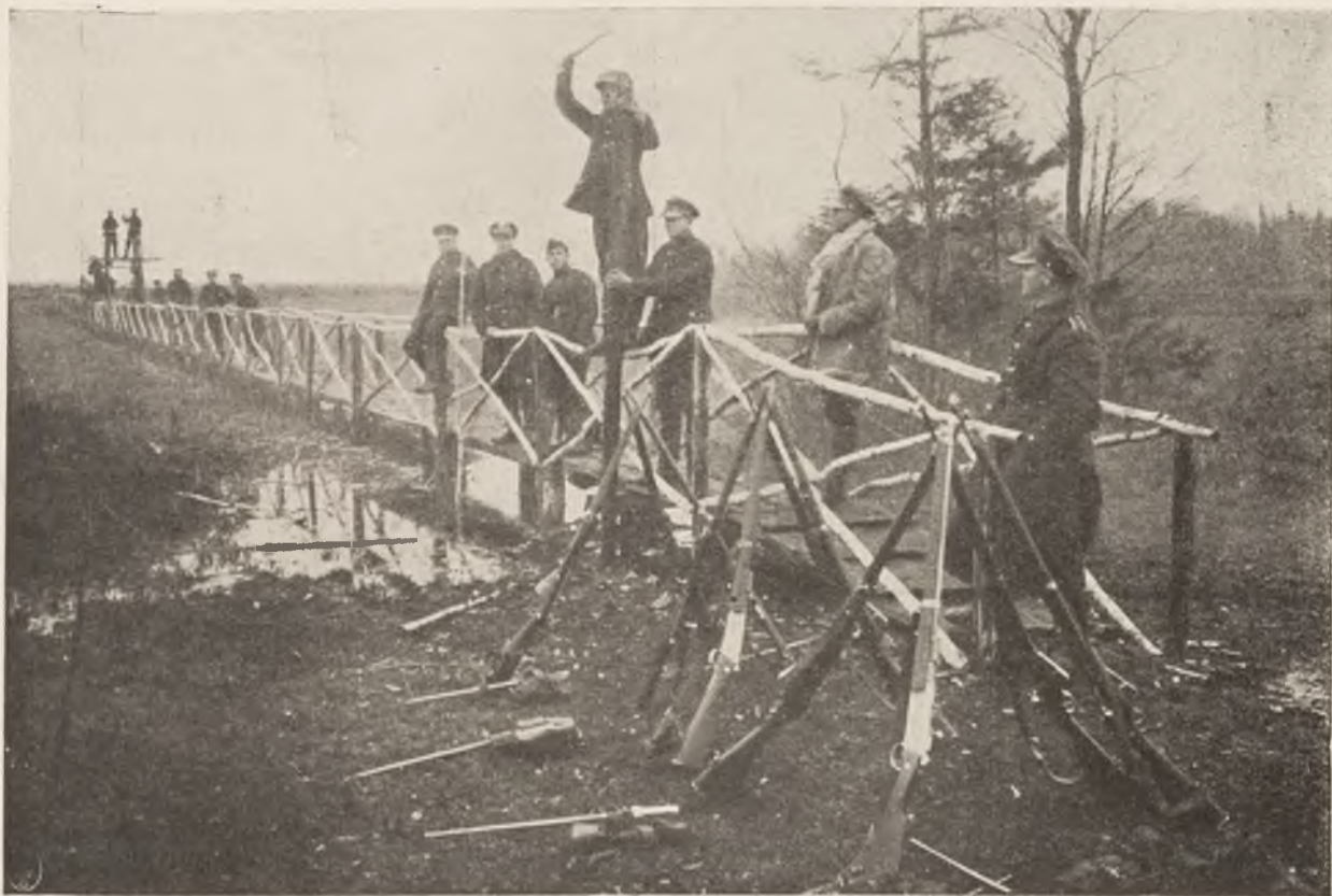
Z Korpusu Ochrony Pogranicza — budowa kładki
