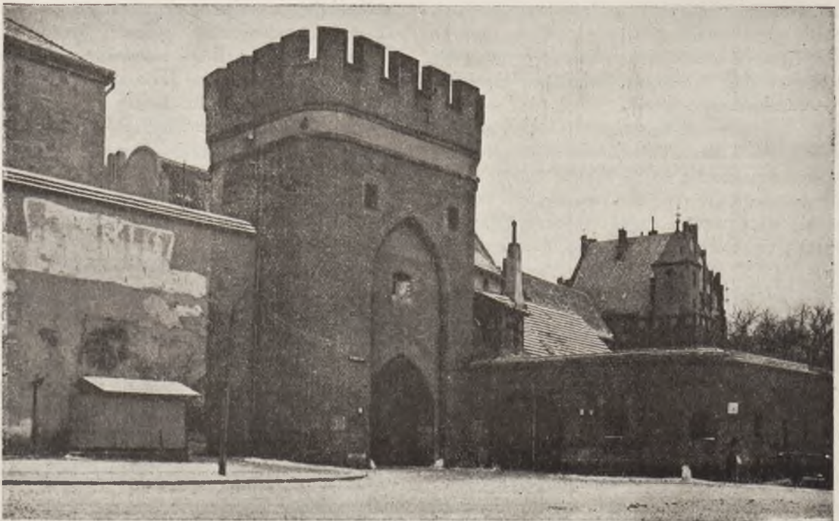
Toruń. Brama wjazdowa i resztki murów obronnych
