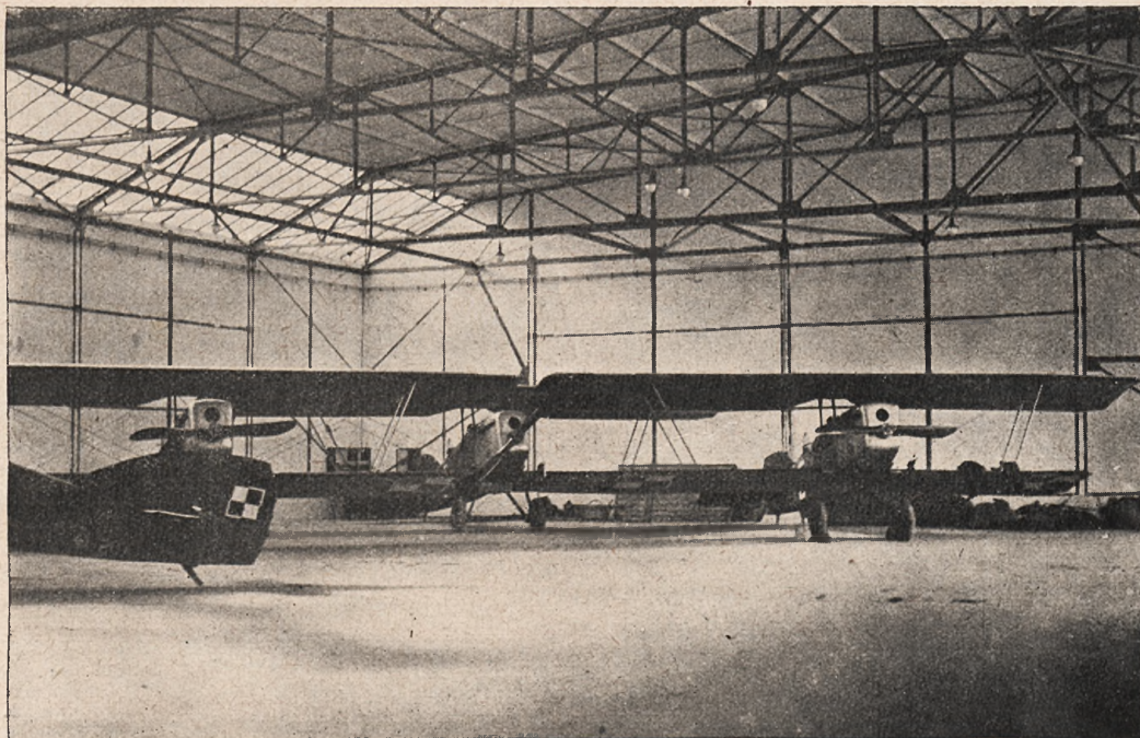
Hangar wykonany przez warsztaty Górnośląskich Zjednoczonych Hut Królewskiej i Laury.
