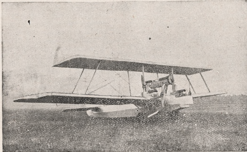
Aparat „Caproni 79“ do ciężkiego bombardowania o motorze 2.000 koni. — Aparat ten jest w stanie zabrać 2.000 kg. bomb.
