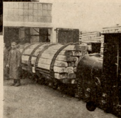
Wyciąganie nasycanych materiałów z cylindra przy pomocy parowozu
