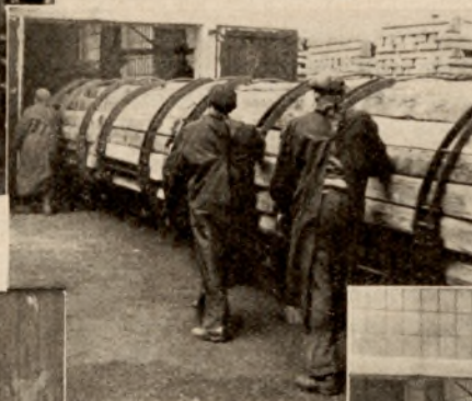
Wtaczanie wózków z nasycalnią drewnianą do cylindra
