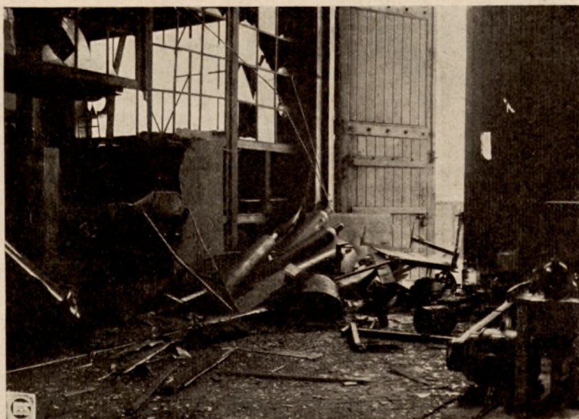
Na zdjęciu przedstawione są skutki rozerwania 40-litrowej butli stalowej, zawierającej sprężony tlen
