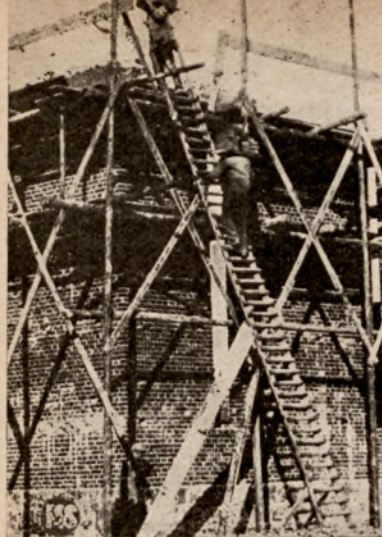
Rys. 1. Drabina o gęstej szczeblowinie stosowana przy rusztowaniach stojakowych
