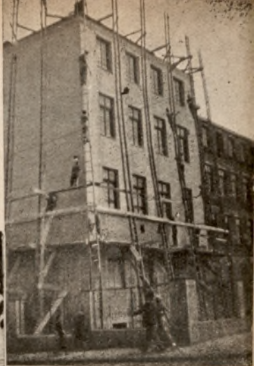
Rys. 4. Rusztowanie boczianowe stosowane do wysokiego budynku
