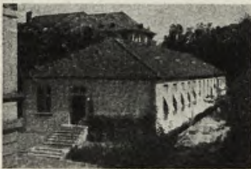
Rys. 5. Zurych. Szpital kantonalny.
