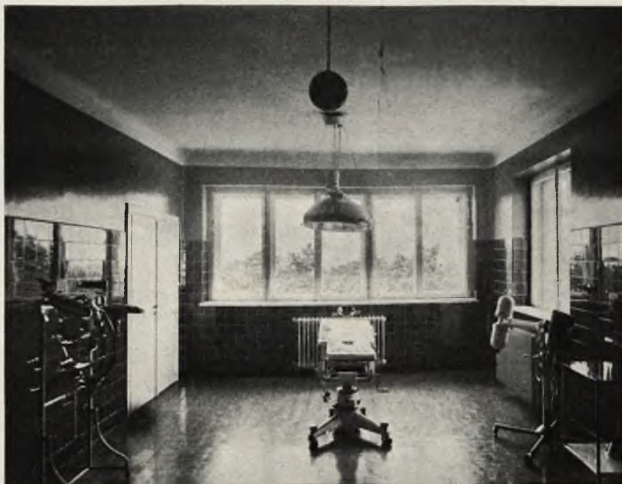
Rys. 2. Sala operacyjna Sanatorium w Otwocku.
