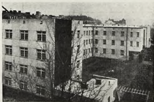
Rys. 2. Widok szpitala od ogrodu.
