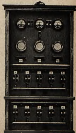
Rys. 6 Odbiornik obsługujący 10 pętlic sygnalizacyjnych
