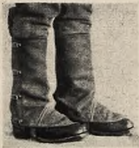
Getry płócienne lub azbestowe, nałożone na buty, stanowią doskonałą ochronę przy niebezpiecznych pracach (Arbeitsschutz)
