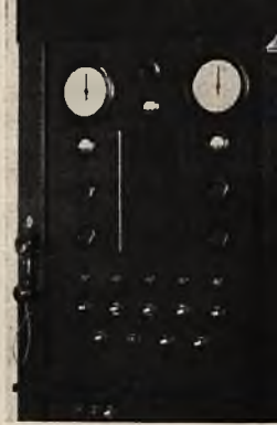
Rys. 7 Centrala odbiorcza o dwóch przyrządach wskazówkowych. W lewej części tablicy przyrządy sygnalizacyjne w pracy — urządzenie do ładowania akumulatorów
