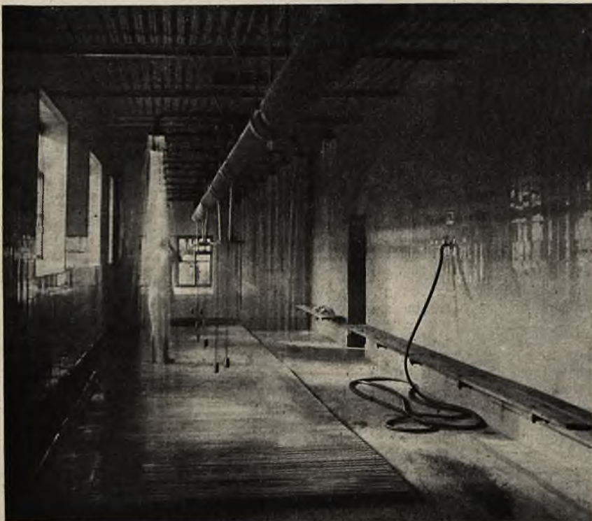
Zdjęcia z terenu Zakładów Hutniczych „Giesche” S. A.
