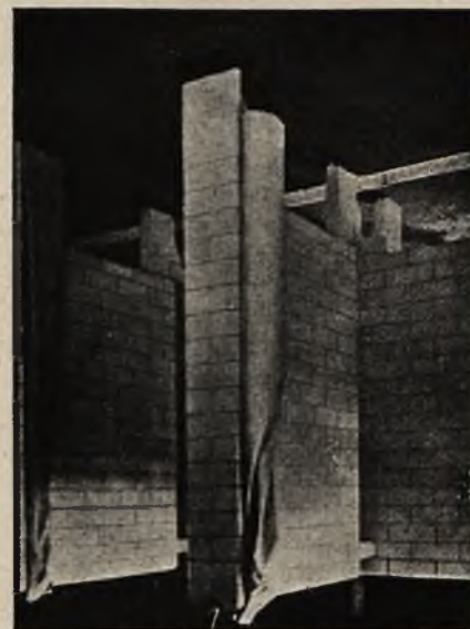
Rys. 9. Kabiny natryskowe trójścienne z zastonami
