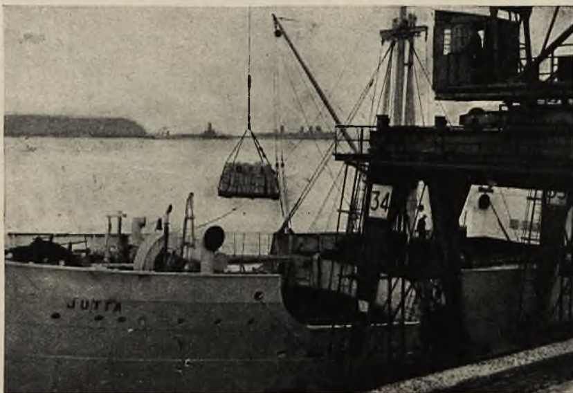
(3) Wyładunek korka przy pomocy dźwigu portowego oraz platformy (planki) zawieszanej na haku dźwigu. Hive znajduje się w powietrzu
