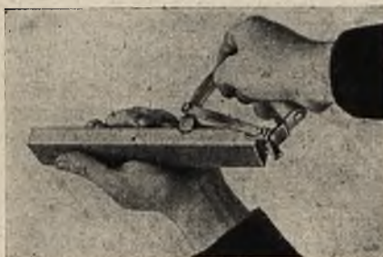
Rys. 6 Wkładanie drzewca do rękojeści przesuwadła
