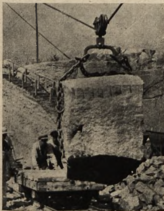
Ładowanie przy pomocy żurawia granitowego bloku na lorcę
