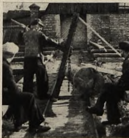
Stosowanie lisicy automatycznej w tartaku przy ładowania dłużyc
