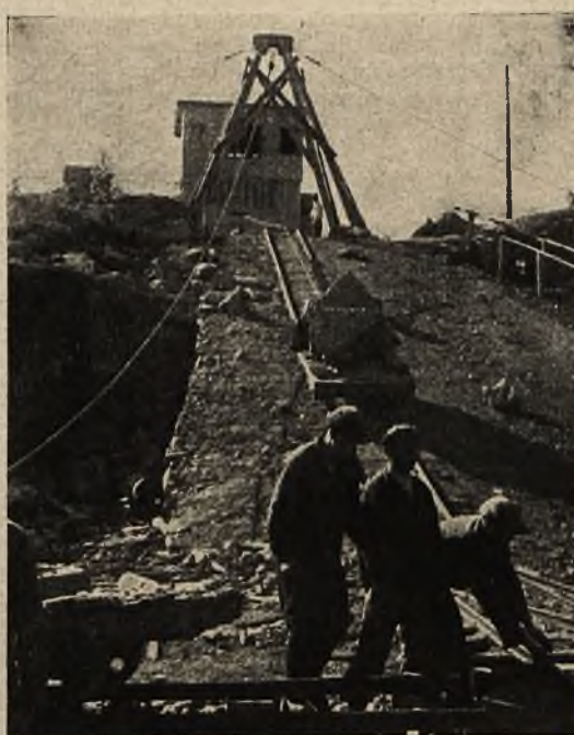
Rozbudowa: pochylni w kamieniołomie
