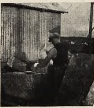
Obrabianie bloku granitowego
