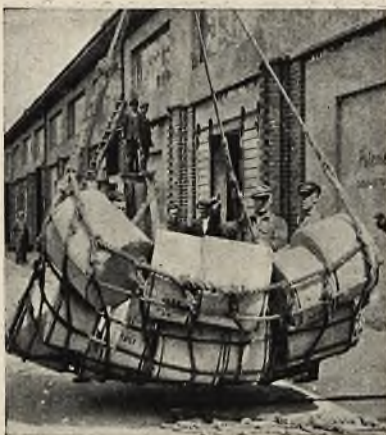
(2) Zdjęcie przedstawia wyładunek papieru ze statku przy pomocy dźwigu portowego. Ładunek umieszczony jest w siatce zawieszanej na haku dźwigu
