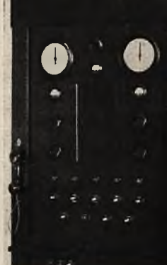
Rys. 7 Centrala odbiorcza o dwóch przyrządach wskaźkowych. W lewej części tablicy przyrządy sygnalizacyjne w prawej — urządzenie do ładowania akumulatorów
