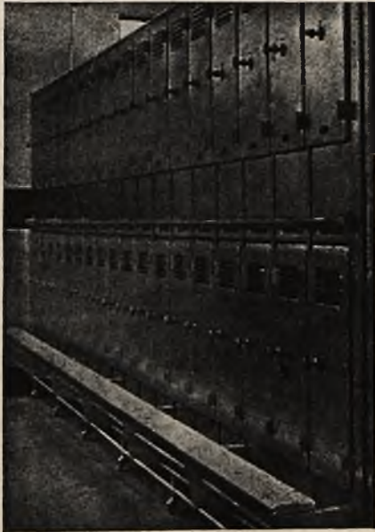
Rys. 1 Szafki szatniane piętrowe
