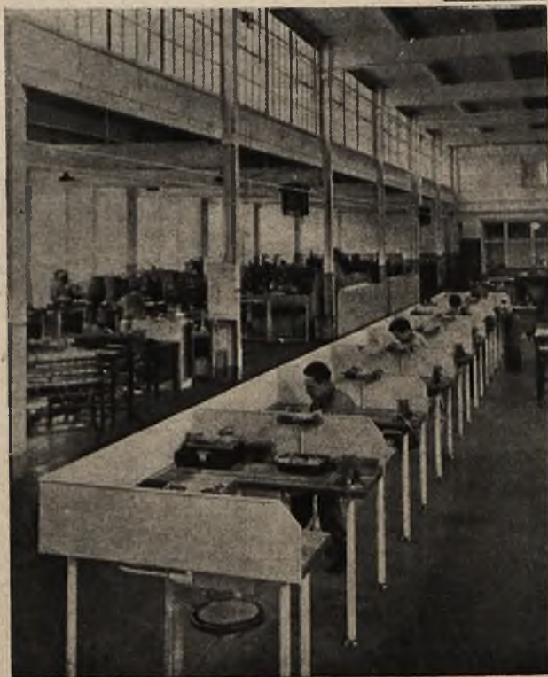
Na ilustracjach — u góry hala w fabryce konfekcji odzieżowej, u dołu hala montażowa w fabryce urządzeń ogrzewniczych
