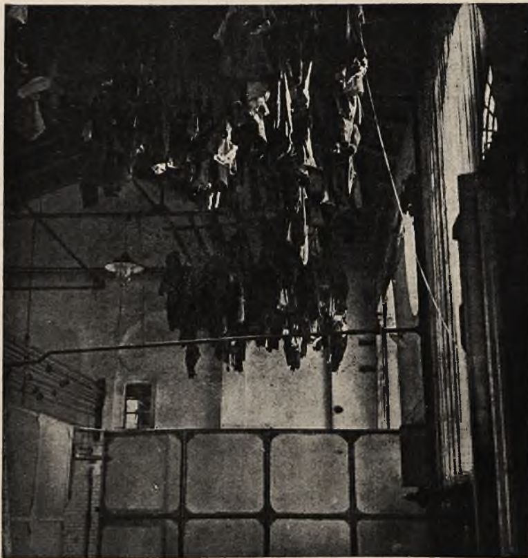
Rys. 8. Stłoczenie ubrań w szatni linkowej. W tej samej hali natryski za ścianką z płyt szklanych w metalowych ramach:
