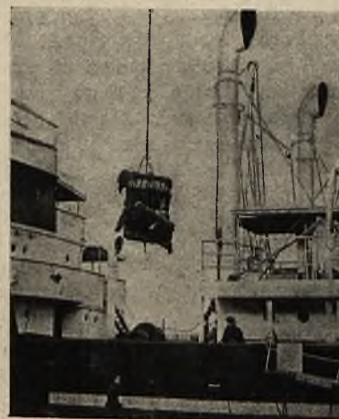
(9) Wyładunek bawełny przy pomocy lin (sztropów) w chwili gdy hive znajduje się w powietrzu nad luką. HIVE związany jest nieprawidłowo: niezaciągnięty pętłą, sztrop niedobity, co groziło jak widać na zdjęciu rozsypaniem się hivu lub wypadnięciem balotu
