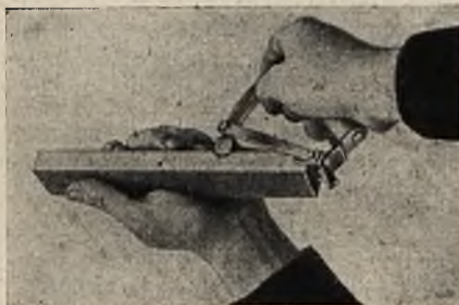
Rys. 6 Wkładanie drzewca do rękojeści przesuwadła
