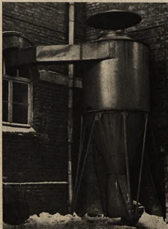
Z lewej strony: osadnik zainstalowany w Wzorcowni Urządzeń Ochronnych w Warszawie, z prawej strony: duży osadnik typu „Cyklon” do zbierania kurzu i nieczystości
