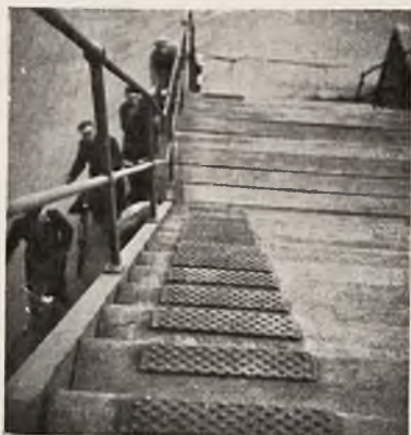
Zabezpieczenie stopni na schodach w Zakładach „The London Brick Company Ltd.” (fot. S. Michalski)
