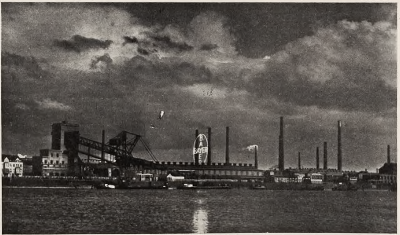
Ogólny widok zakładów koncernu I. G. Farbenindustrie w Leverkusen
