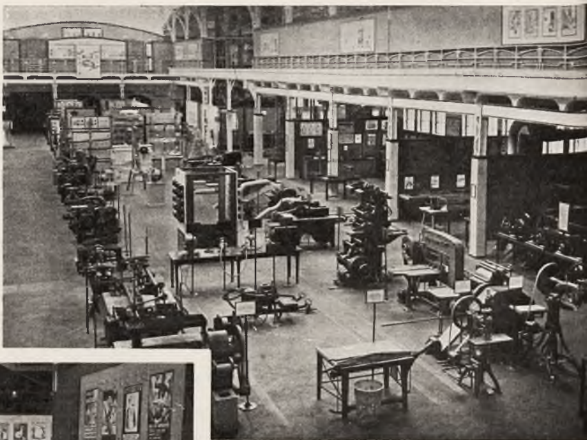
Hala Muzeum Bezpieczeństwa Pracy w Charlottenburgu mieszcząca z górą 100 obrabiarek zaopatrzonych w osłony, silniki, pędnie i urządzenia przeciwpożarowe.
