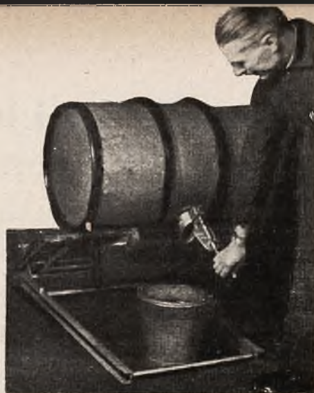
Wytaczanie beczki na wózku o ramie żelaznej. Obrót beczki i wylewanie płynów ułatwia rączka przy otworze szpuntu. Rączka wykonana jest z rurki metalowej, przez którą przy wylewaniu z beczki wchodzi do beczki powietrze. Zapobiega to rozpryskowi płynu (eksp. Wzorcowni)
