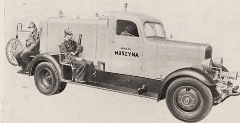
Znormalizowana autopolewaczka przystosowana do celów pożarniczych i OPL wykonana przez firmę Liefeldt i Schiffner
