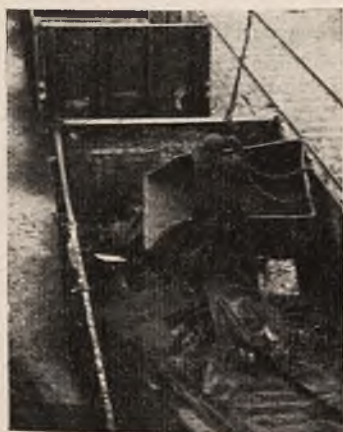
Fot. 8 Zahaczanie toby po jej opróżnieniu na hak dźwigu
